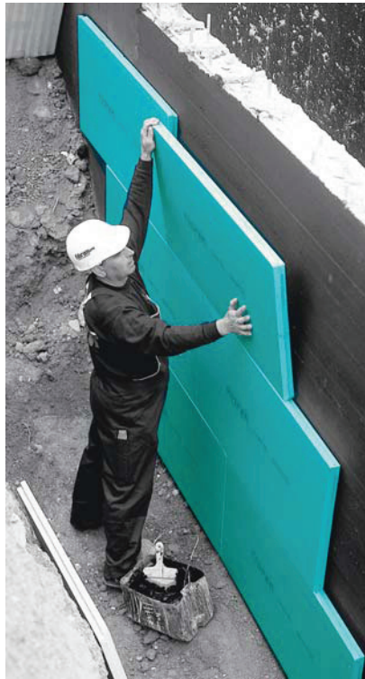
Protecção mecânica da membrana de impermeabilização e simultaneamente isolamento térmico do piso enterrado com FIBRANxps 300-L
