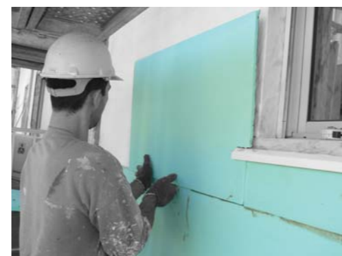
Aplicação de FIBRANxps ETICS GF junto a uma janela
