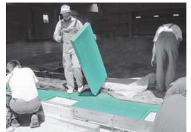
Isolamento térmico de um pavimento muito carregado com FIBRANxps 500 – L
