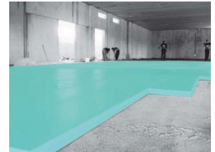
Isolamento térmico de pavimentos com cargas elevadas com FIBRANxps 300-L
