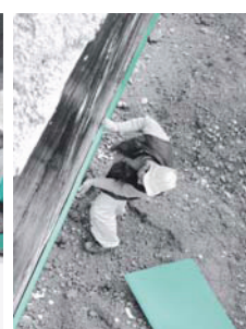
Fixação de placas FIBRANxps 300-L na membrana de impermeabilização da parede enterrada com adesivos FIBRANstick.
