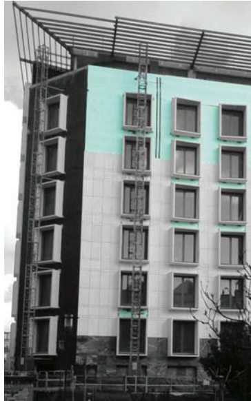
Fachada ventilada com isolamento FIBRANxps MAESTRO
