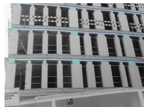
Isolamento térmico de pontes térmicas através da utilização de FIBRANxps ETICS
