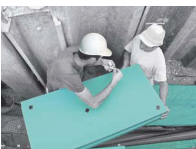
Fixação de placas FIBRANxps 300-L na membrana de impermeabilização da parede enterrada com adesivos FIBRANstick.
