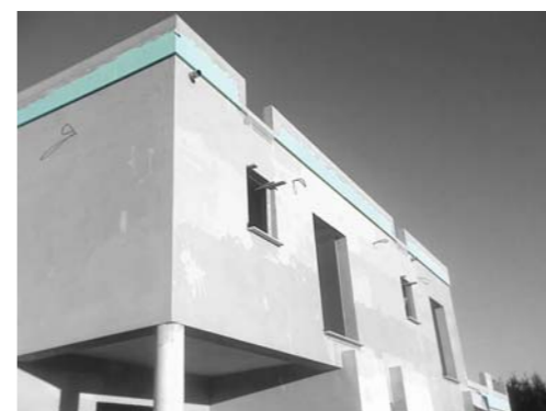
Rodapé de fachada na cobertura com FIBRANxps ETICS GF
