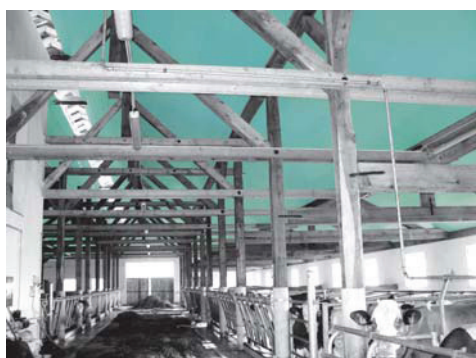
Isolamento térmico visível com FIBRANxps MAESTRO
