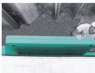
Fixação de placas FIBRANxps 300-L na membrana de impermeabilização da parede enterrada com adesivos FIBRANstick.
