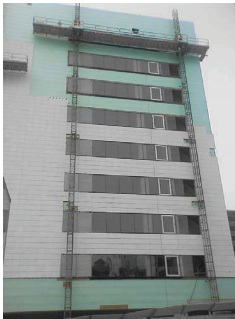
Fixação de isolamento FIBRANxps MAESTRO com buchas FIBRANfix
