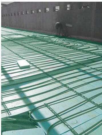
FIBRANxps 300 – I sob pavimento radiante
