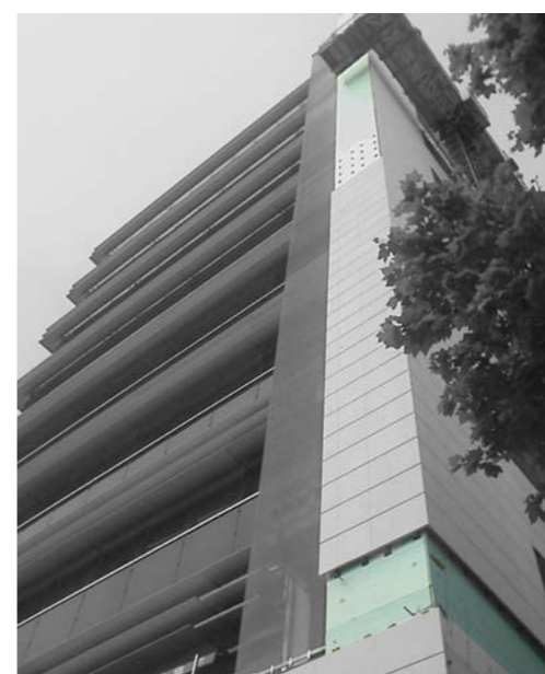
Isolamento térmico em Fachada Ventilada
