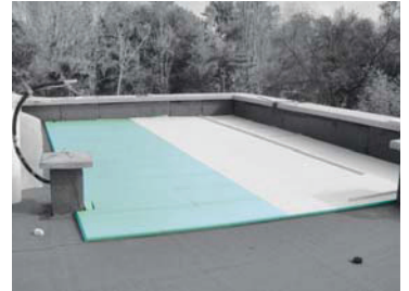
Cobertura invertida isolada com FIBRANxps 400 – L
