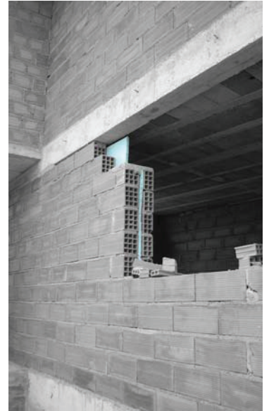
Parede dupla com FIBRANxps MAESTRO no interior
